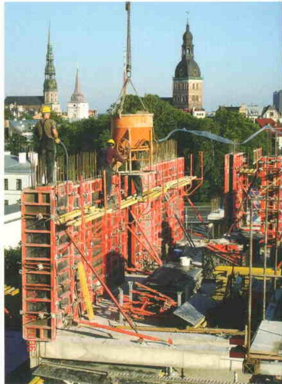
Jaunbūvējamo korpusu starpstāvu pārsegumi tika izbūvēti 160 mm biezumā, stiegojot tos divās kārtās – ar apakšējo un augšējo stiegrojumu ar 100 un 200 mm soli. Septīta stāva pārsegums tika izbūvēts 250 mm biezā. Uz garāzas ēkas izbūvējamās trīsstāvīgā daļas pamatne tika projektēta kā masīva ribota platforma, kuru veido 250 mm bieza plātnē ar 700 mm platām un 850 mm augstām ribām.
